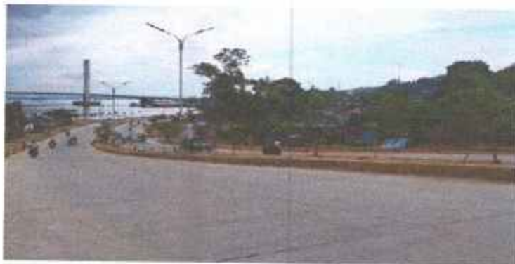
Gambar. 18. Akses Jalan Ke Pantai Toronipa Konawe
